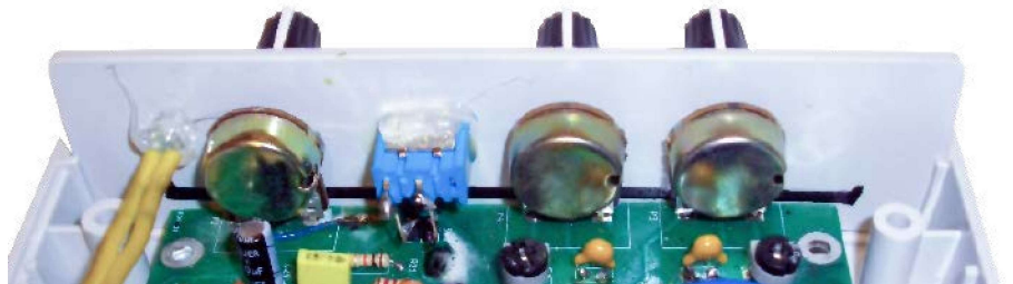
Fotografia 7. Montaż przedniego panelu odbiornika w obudowie
