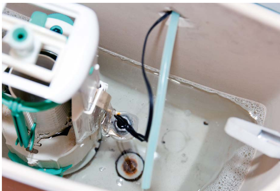
Rysunek 1. Schemat instalacji dozownika i sposób montażu czujnika poziomu
